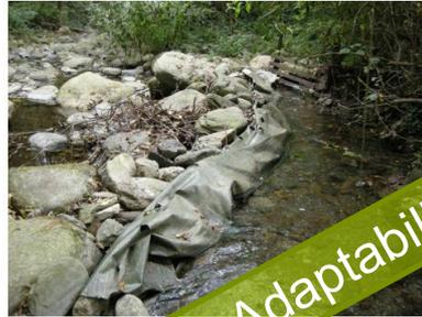
FIGURE 5.4 – Photo d'un seuil partiellement étanche (Canal de la Literà)
