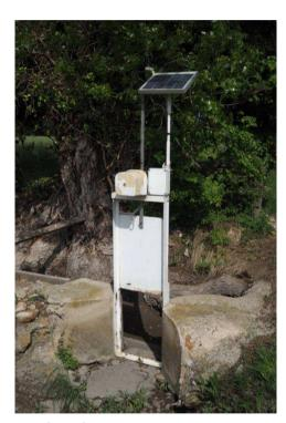
Système à ouverture et fermeture motorisées et alimenté par panneau solaire 10% des agriculteurs équipés
