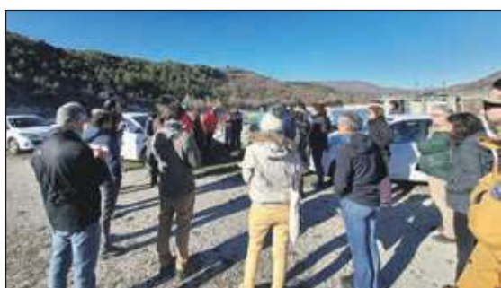
Ils ont ensuite pu effectuer une visite du barrage de la Laye afin d'y évoquer les enjeux réglementaires.
